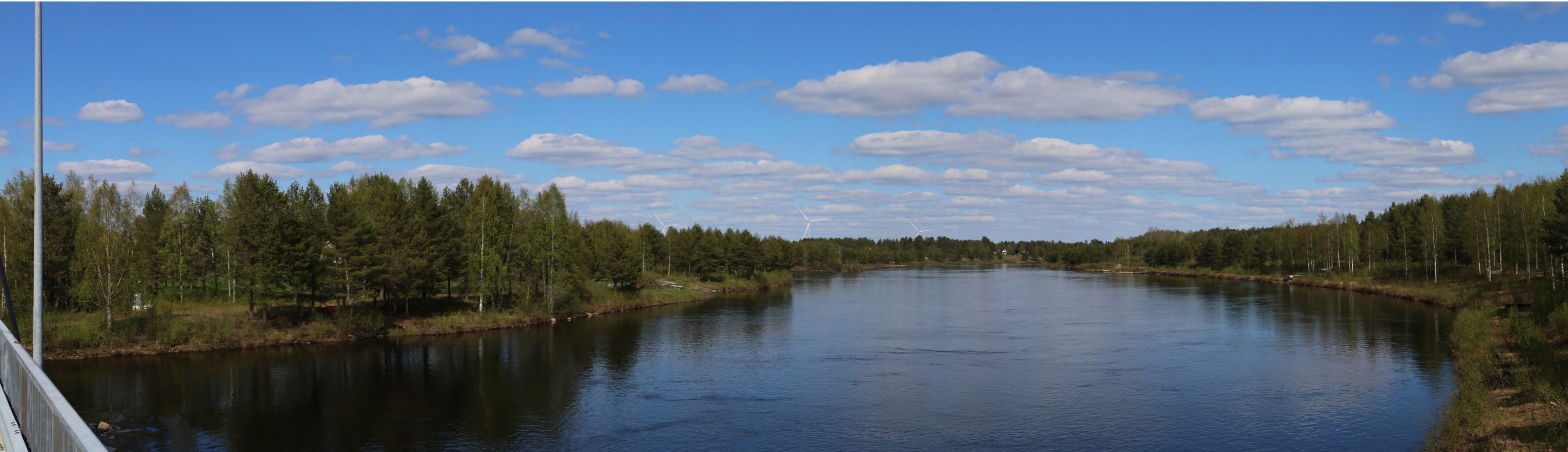
Havainnekuva 5 valtatie 4 varressa kulkevalta pyöräily sillalta lijoen pohjoisemman uoman kohdalta. Etäisyys lähimpään voimalaan on noin 4,9 kilometriä. (koostettu panoraama, kuvattu 50 mm polttovälillä)
