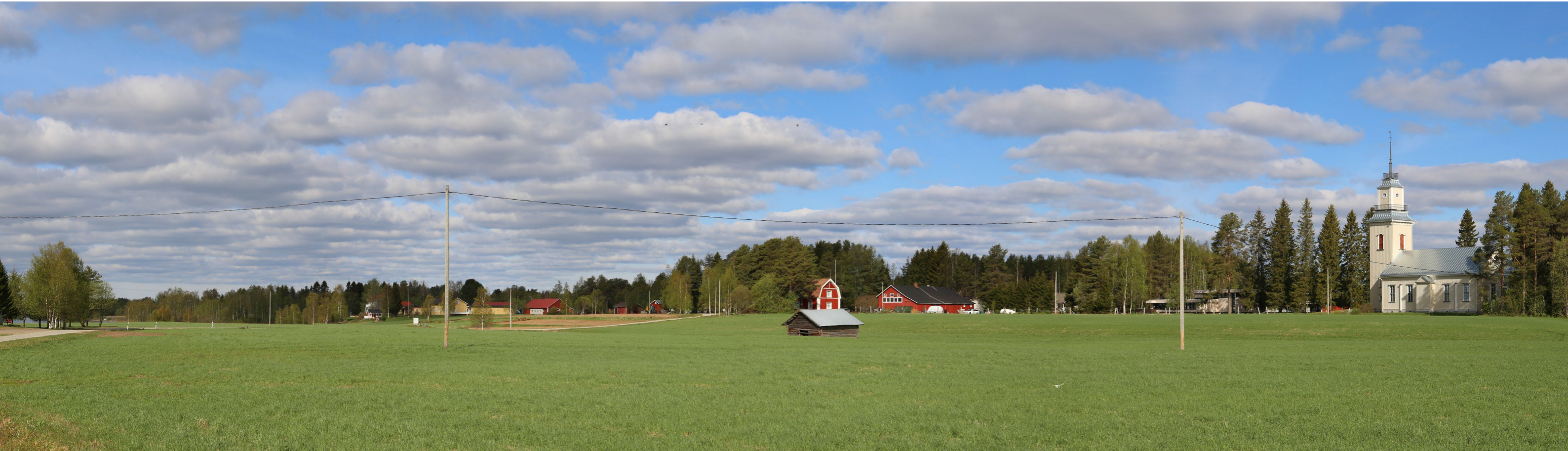
Havainnekuva 13 Yli-lin kirkonseudun maakunnallisesti merkittävästä rakennetusta kulttuuriympäristöstä. Etäisyys lähimpään voimalaan on noin 16,9 kilometriä. (koostettu panoraama, kuvattu 50 mm polttovälillä)
