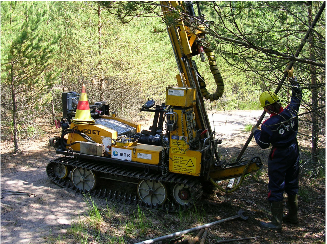
Kuva 2. Maaperäkairausta kevyellä GM50-kairakoneella. Kuva T. Rauhaniemi, GTK
