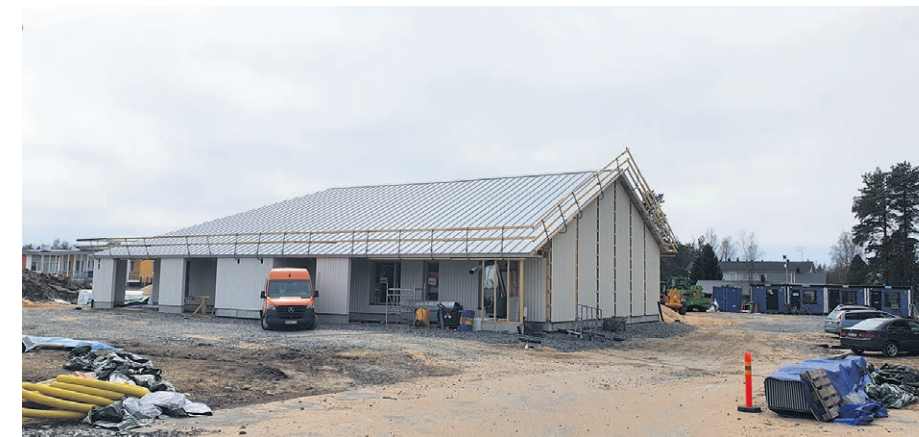
Ensi vuoden alussa käyttöön otettava kunnan uusi Haminan päiväkotia vähentää varhaiskasvatuksen vuokra- ja väliaikaistilojen tarvetta. Haminan koulun viereen Kirkkotielle valmistuvasta 138 paikkaisesta päiväkodista tulee kunnan toiseksi suurin Nikkarin päiväkodin jälkeen.
