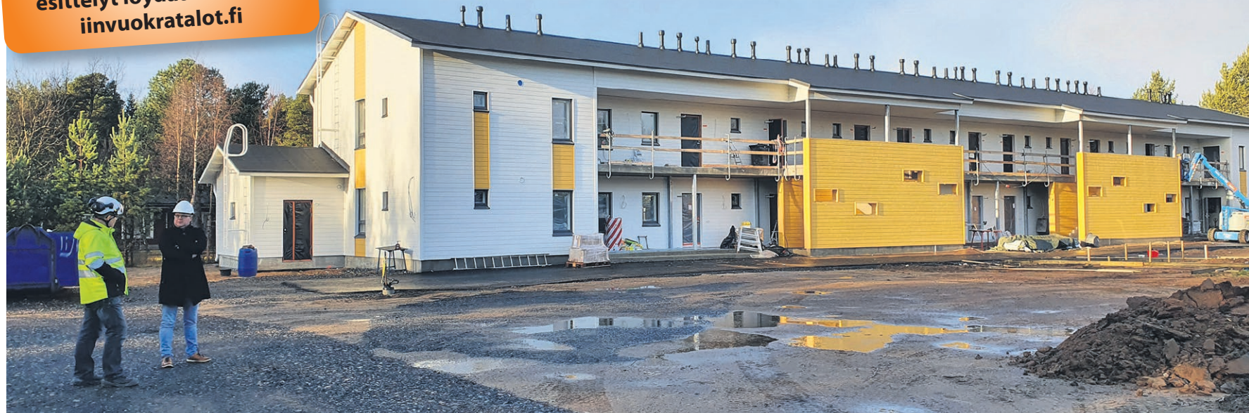
Tornikujan tontilla on rakennusoikeutta toiselle samankokoiselle luhtirakennukselle. Tontilla sijaitsi aiemmin kaksi huonokuntoista rivitaloa, jotka purettiin pois.
