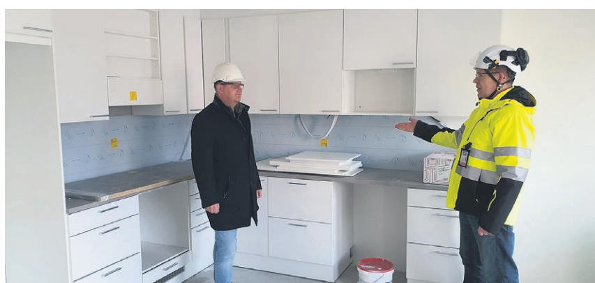
Luhtitalossa viimeistellään parhaillaan sisäpintoja kuntoon. Kuvassa vasemmalla Iin Vuokratalot Oy:n toimitusjohtaja Antti Tuomaala ja oikealla Rakennusliike Häyrynen Oy:n laskenta- ja hankintapäällikkö Janne Häyrynen.
